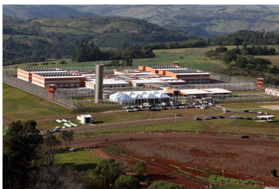
Foto panorâmica da Penitenciária Federal de Catanduvas/PR
